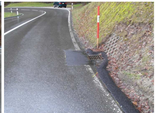
Versetzen des Ablaufgitters
