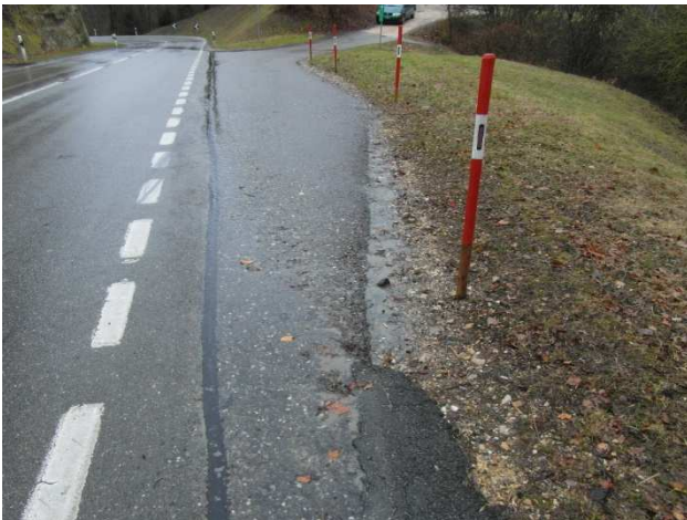
Entfernen einer Leitplanke
